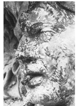
Abb. 16: Steinhauermässige „Reinigung“ an einem Wasserspeier in Würzburg. Aus [Wihr S.103]. Diese Methode widerspiegelt Unkenntnis und ist in dieser miserablen Ausführung als Vandalismus zu bezeichnen.
