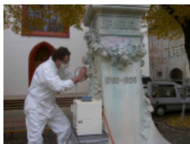
Abb. 4: Mit dem Partikelstrahlgerät können hartnäckige Verschmutzungen kontrolliert reduziert, und schwarze Krusten ausgedünnt werden. Hebel-Denkmal, Basel.
