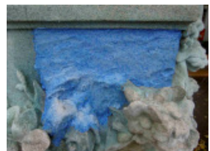
Abb. 5: Mit der Kompressenmethode und den richtigen Wirkstoffen lassen sich gewisse Verfärbungen chemisch entfernen. Hier waren grüne Kupfersalze der oben stehenden Bronzestatuette in den Stein eingedrungen. Aus deren Reaktion mit dem Komplexbildner resultiert eine Blaufärbung der Komresse. Hebel-Denkmal, Basel.
