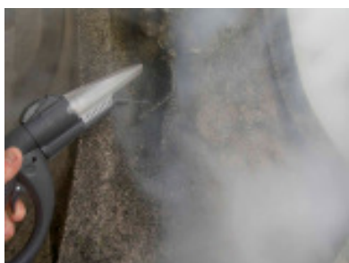
Abb. 3: Die Reinigung mit dem Feindampfstrahlgerät ist schonend und zeigt bei porösen, heiklen Untergründen sehr gute Resultate. Hier auf „pierre d'Euville“, ein porenreicher bioklastischer Kalkstein. Hebel-Denkmal, Basel.
