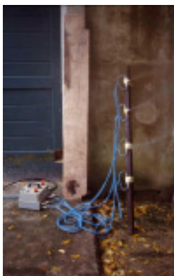
Abb. 6: Mit einem Wasservernebler können Verschmutzungen über den Faktor Zeit gelöst werden, ohne viel Wasser in das Objekt einzutragen. Im Bild vier weisse Sprühdüsen an einem Trägerstab.
