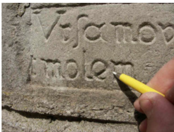
Abb. 12: Wenn z.B. vor einer Festigung noch trocken vorgereinigt werden muss, können mit Glasfaserstiften gute Ergebnisse erzielt werden. Im Bild die Reinigung von Inschriften und Reliefs C.G. Jungs an seinem Turm in Bollingen.
