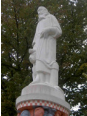
Abb. 9: Wettsteinbrunnen Basel. Die 60-jährige Brunnenfigur aus Laufener Kalkstein wird regelmässig mit einer Javellewasser-Lösung gereinigt und ist so „weiss“ wie nie zuvor..
