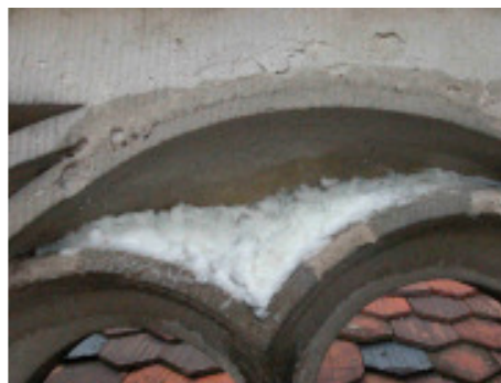
Abb. 7: Cellulose kann als Trägermaterial für chemische Wirkstoffe dienen. Im Bild eine Kompressen zur Gipsumwandlung (Ionentausch) mit Ammoniumcarbonat, an einer Masswerkbrüstung am Berner Münster.
