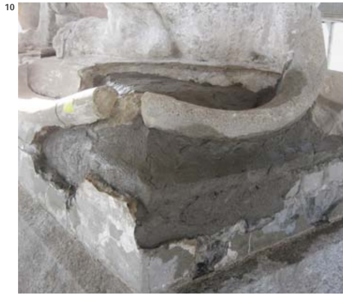
10 Wiederaufbau der Form mit Kernmörtel
