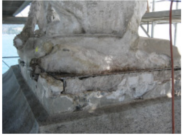
Abb. 11: Der Turn-around. Man beachte den in den Ecken genieteten T-Träger-Rahmen.
