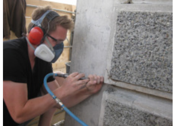
Abb. 41: Linus Wettstein, Steinmetz und Student Bachelor of Arts in Conservations HKB, beim Freilegen mit feinen Pressluftwerkzeugen.
