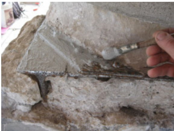
Abb. 31: Die geschmirgelten T-Träger werden mit einer korrosionshemmenden Haftschäume bestrichen.
