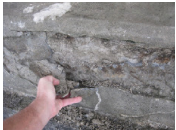
Abb. 25: Ablösen grosser Schalen und Mürbzonen am Löwensockel. Die Schalen bestanden aus sehr hartem, früher angetragenen Mörtel (1971?).
