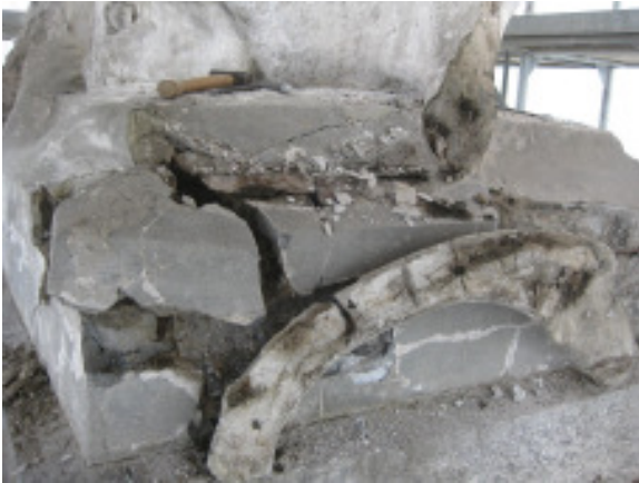
Abb. 10: Beim Freilegen / Ablösen. Durchfeuchtung und dadurch Frost- und Salzsäden unter der Oberfläche.
