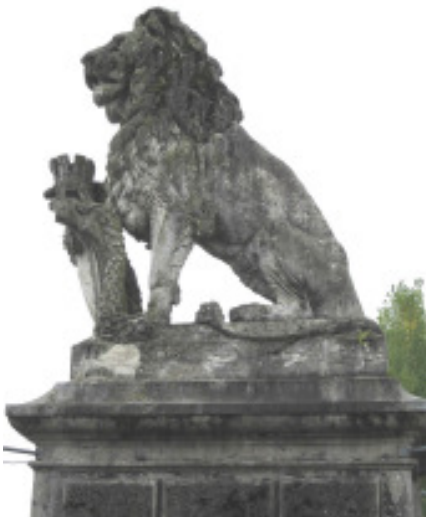
Abb. 2: Vorzustand im Dezember 2011.
