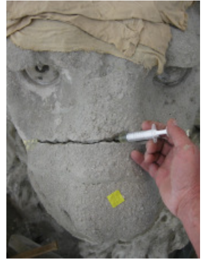
Abb. 35: Nebst zwei Dübel über das Maul wurden ca. 500ml EP in den Schnauzenriss gespritzt.
