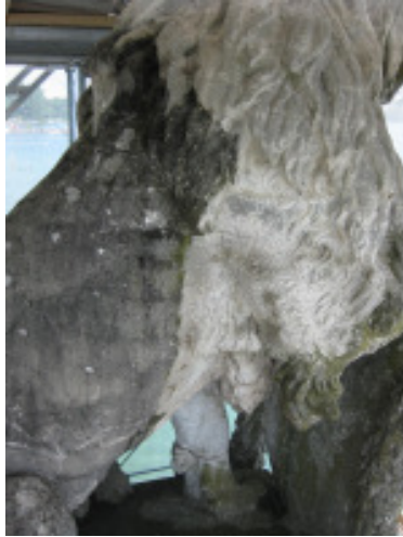
Abb. 19, 20, 21: Wegen den hohen Gewässerschutzauflagen erfolgte die Reinigung des Löwen grundsätzlich kontrolliert von Hand mit diversen Bürsten und relativ wenig Wasser aus der Sprühflasche unter stetigem Absaugen des Schmutzwassers.
