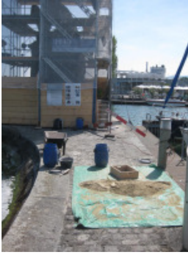
Abb. 14: Auf der Mole werden die lokalen Sande getrocknet, ausgesiebt und zur Baustellen-Eigenmischung mit definierter, empirisch erprobter Rezeptur verarbeitet. Im Hintergrund der Löwenzwinger.
