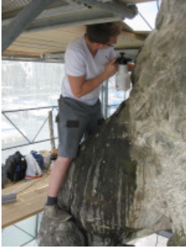
Abb. 19, 20, 21: Wegen den hohen Gewässerschutzauflagen erfolgte die Reinigung des Löwen grundsätzlich kontrolliert von Hand mit diversen Bürsten und relativ wenig Wasser aus der Sprühflasche unter stetigem Absaugen des Schmutzwassers.
