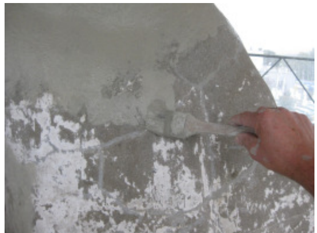
Abb. 39: Applikation der Schutzschlämme. Darunter sind Risskittungen und Reste der weissen Schlämme sichtbar.
