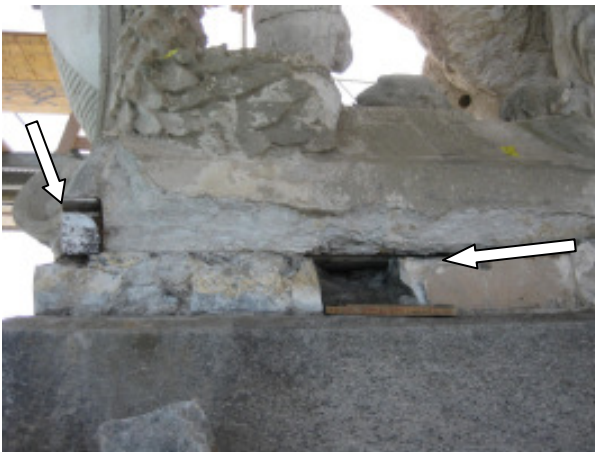
Abb. 29: Pfeil links weist auf geschmirgelten T-Träger, Pfeil rechts markiert die Unterkante (UK) des Löwengusses. Zwischen UK und Granitplatte ist ca. 10cm Ausmauerung mit Pflastersteinen.
