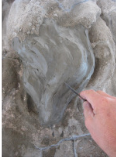
Abb. 27: Nach Ansteifen des Deckmörtels wird die Form bildhauerisch ausgekratzt.
