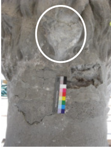
Abb. 26: Rissbild und Fehlstellen am Rücken. Kreis zeigt Zone des grossen abgefallenen Haarbüschel.
