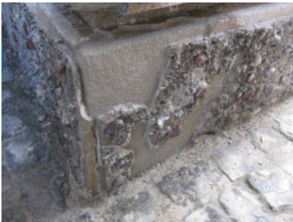
Abb. 36: Quader am Postament mit Kernmörtel. Wenn möglich wurden bestehende Originalteile als „Puzzle“ wieder angeklebt (mittlere Flächen).
