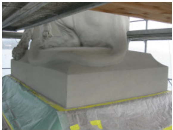
Abb. 13: Schlusszustand, geschlämmt.
