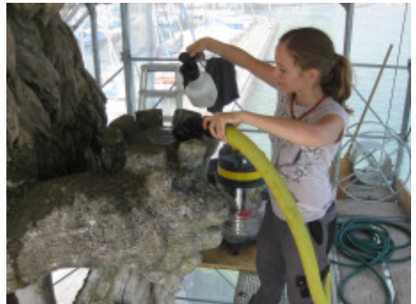
Abb. 43: Andrea Spöhl, Malerin und Studentin Bachelor of Arts in Conservations HKB, bei der Feuchtreinigung mit Absaugvorrichtung.
