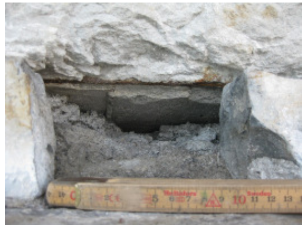
Abb. 30: Detail aus Abb. 26. Die Freilegung ermöglicht den Blick auf die Standfläche des Löwen, mit Abdrücken von Holzbrettern darauf. Dies belegt, dass er nicht auf dem Kopf gegossen wurde.
