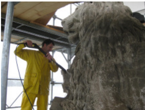
Abb. 22: Zum Schluss erfolgte eine Spülung aus Distanz mit dem Druckreinigungsgerät.
