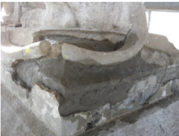
Abb. 12: Wiederaufbau der Form mit Kernmörtel. Die früheren Schwanzergänzungen (ausser dem fehlenden Mittelstück) wurden wieder verwendet.
