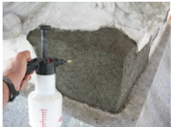
Abb. 32: Die Qualität der mineralischen Mörtel ist entscheidend von der Pflege durch feucht halten abhängig.
